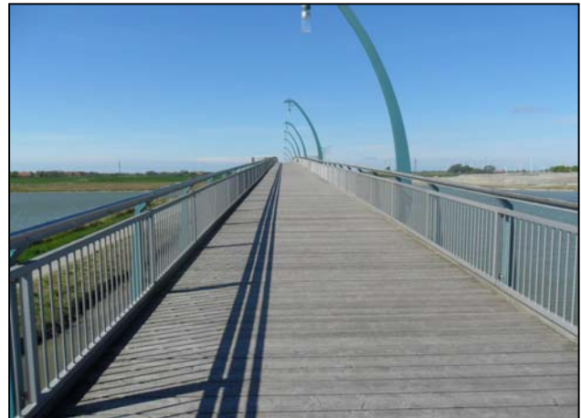
Abb. 7: Brücke, die über das Wangermeer führt
